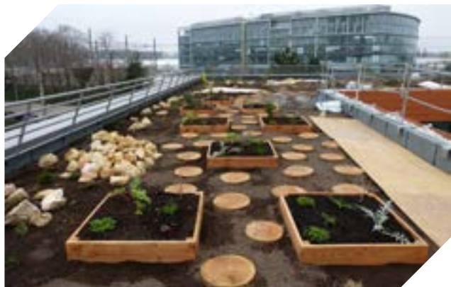
Toiture végétalisée du futur siège social de GTM bâtiment, en cours de réalisation en collaboration entre le SPN, Topager et GTM © S. Cohen
